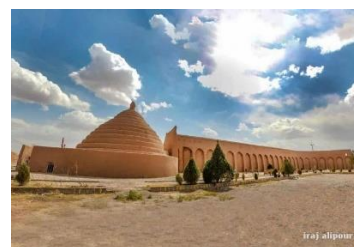
نمای شمال شرقی یخچال عباس‌آباد
